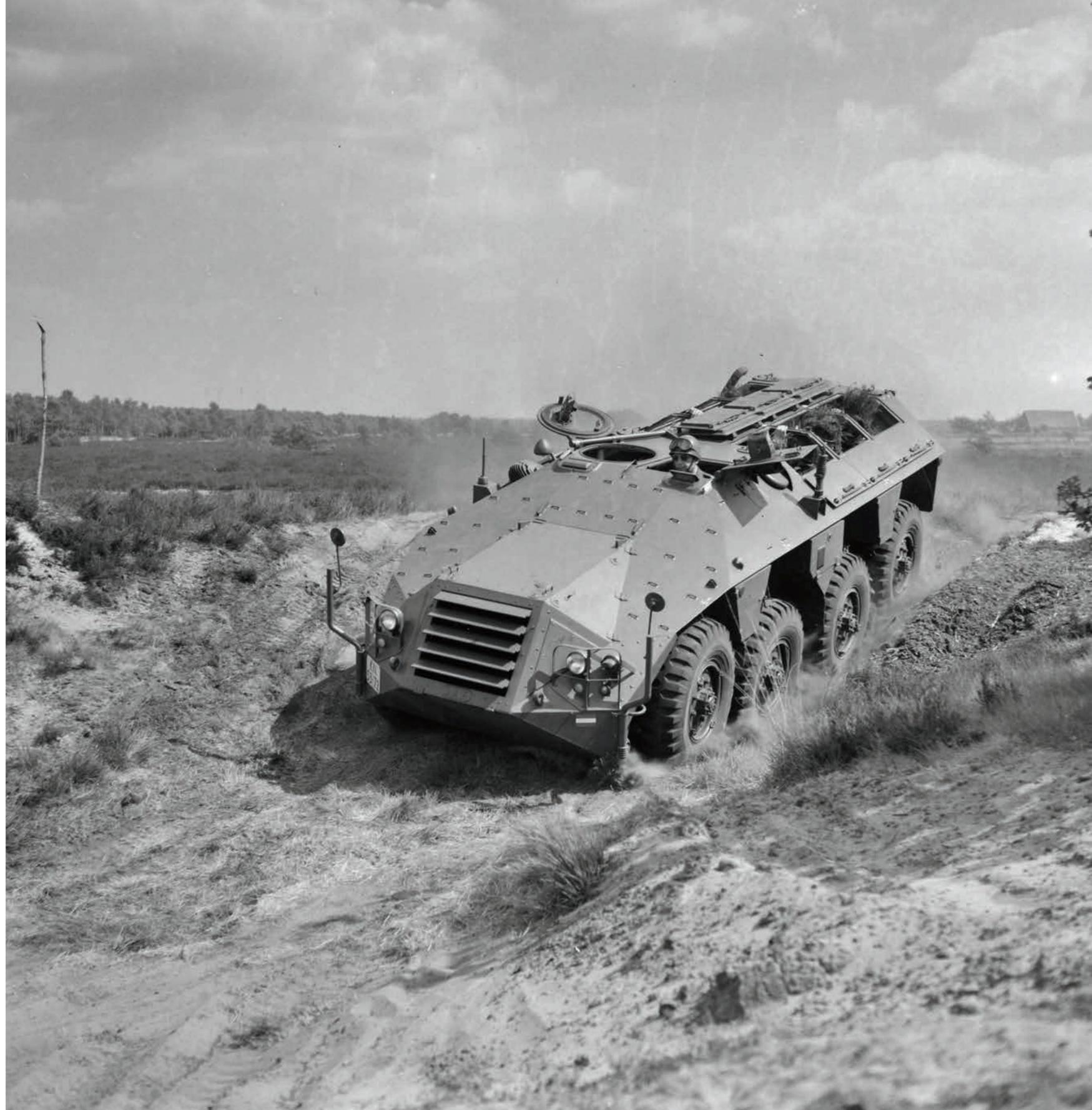
Présentation d'un prototype de l'YP 408 sur la zone d'entraînement d'Oirschot, près d'Eindhoven, le 16 juin 1959. Notez que le toit et le haut des flancs du compartiment de transport pouvaient être ouverts. Sur les YP 408 de série, seul le toit peut s'ouvrir par six grandes trappes.
